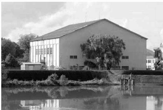
取り壊し予定の旧市民センター
